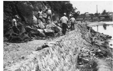
다가산 우회도로 공사
