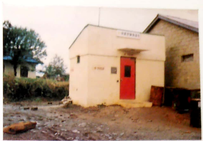
1982. 10. 29 농업용 유류의 원활한 공급을 위하 여 설치한 유류판매취급소.
